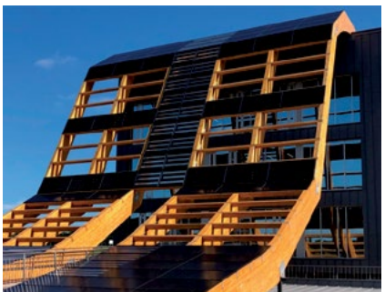
Edificio de Oficinas Asturias 40 kW
